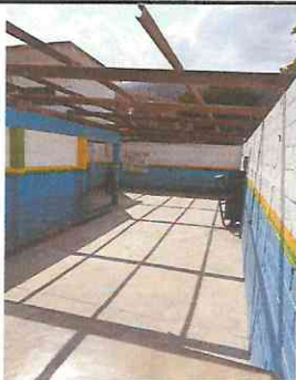
Foto 5: Sustitución de lámina actual (acanalada) en mal estado, por lamina troquelada calibre 26 legitima, en area te patio
