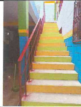
Foto 2: Reemplazo de pintura por pintura anticorrosiva en baranda, hacia el segundo nivel de aula 1 y 2
