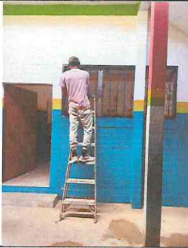
Foto 1: sustitución de pintura existente en malas condiciones de cocina, dirección, aulas, interior y exterior con pintura de color: azul, blanco, amarillo y verde, con pintura a base de agua marca Corona Cromatic
