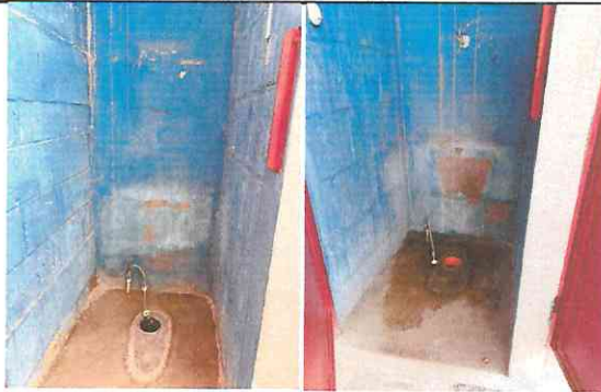
Foto 3: Reemplazo de seis sanitarios en mal estado en area de baños
